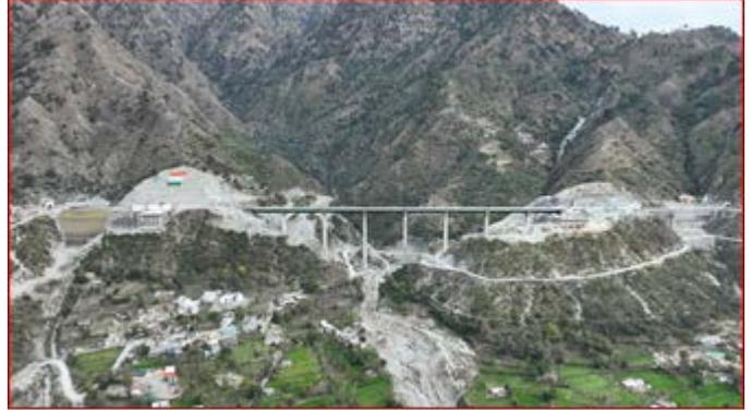
है। इस पुल के निर्माण में नींव के निर्माण की खुदाई एवं भू खुदाई के लिए रू. 7.5 लाख सहित लगभग 36500 सह रैनफोर्समेंट स्टील के 7000 मीट्रिक टन और स्ट्रक्चरल स्टील के 7552 मीट्रिक टन का सह-निर्माण शामिल है। पियर्स की ऊंचाई 35.08 मीटर से 90.53 मीटर तक है। पियर पी 5 की ऊंचाई 90.5 मीटर है जो सबसे लंबा पियर है।
