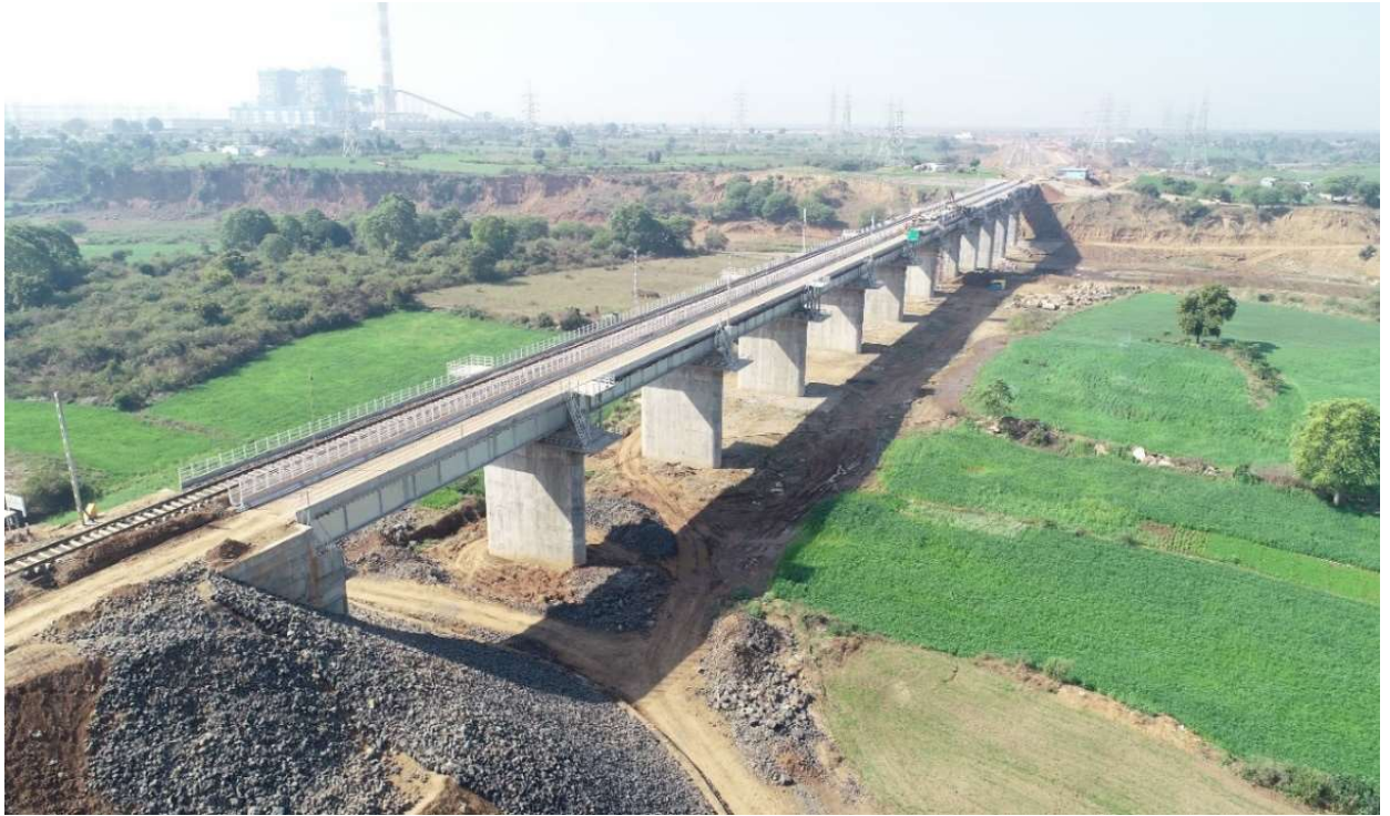
किमी 06/830 पर शकर नदी पर स्थित पुल संख्या 12 (12 X 30.5 मी कम्पोजिट गर्डर)
