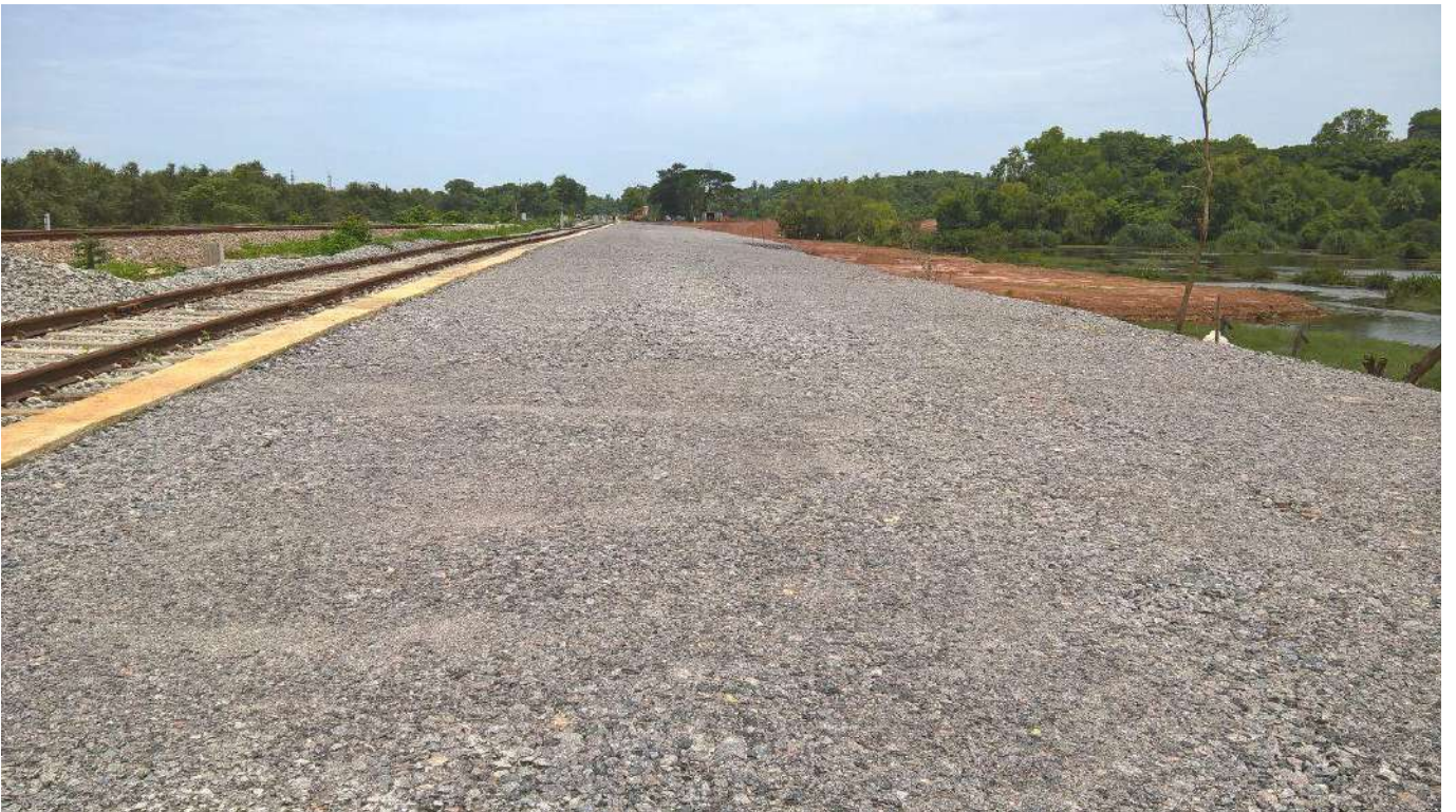
नई परिसंपत्तियों का निर्माण- कर्नाटक में मंगलूरु के पास ठेकुर यार्ड में हाफ-रेक लंबाई का साईडिंग
