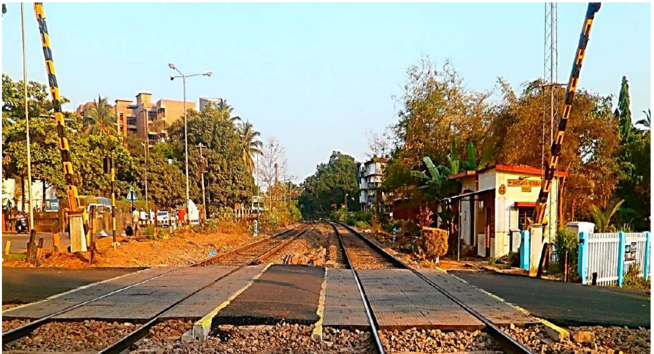
समपार फाटक पर सड़क सतह के लिए रबराइज़ पेवर ब्लॉक
