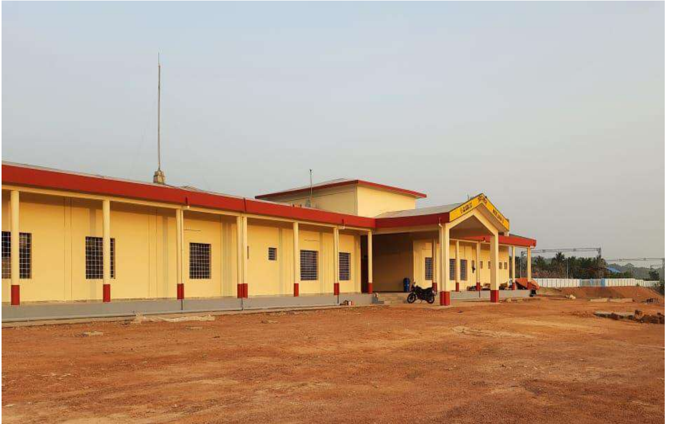
नई परिसंपत्तियों का निर्माण - कर्नाटक में कुमटा के पास मिर्जान स्टेशन
