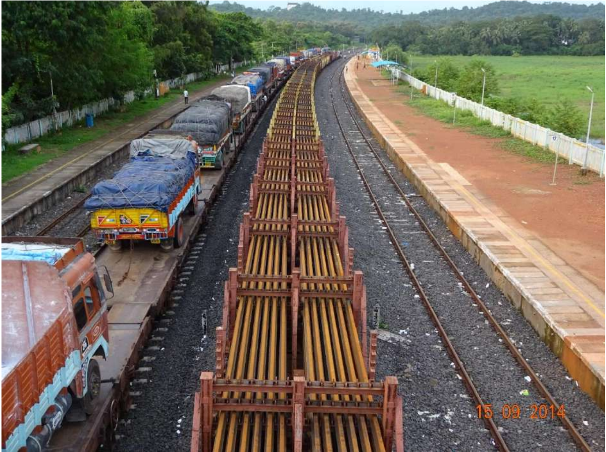
आकस्मिक रेल रिन्यूवल के लिए नए 260 मीटर के रेल पैनल
