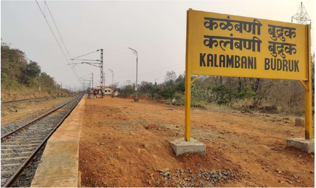
नई परिसंपत्तियों का निर्माण - महाराष्ट्र में खेड के पास कलंबणी बुद्रुक स्टेशन
