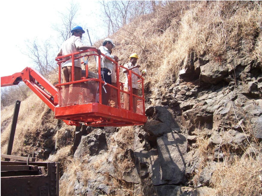
बूम लिस्ट का उपयोग कराते हुए रॉक कटिंगों में निरीक्षण तथा लूज स्केलिंग
